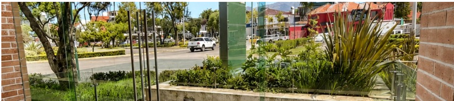
Frente acristalado y acceso principal
