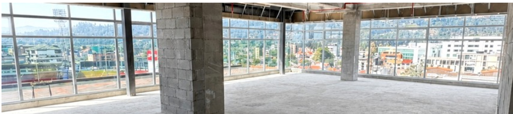
Area principal en obra gris
