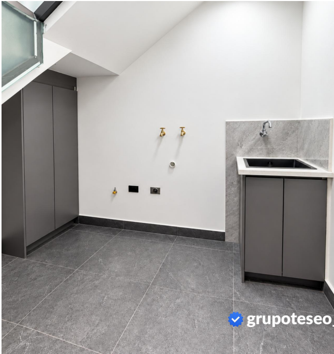
Área de lavandería
