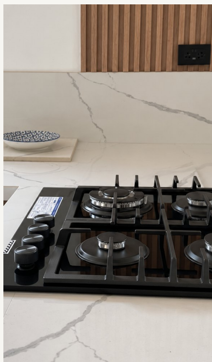
COCINA A GAS
